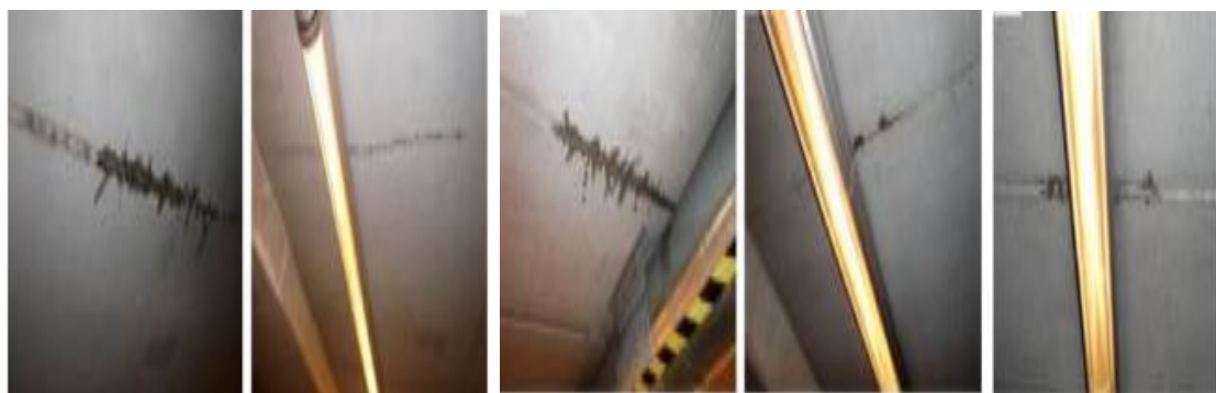
Figura 2.18 Acompanhamento do ensaio de permeabilidade em fissuras tratadas e de controlo (Wiktor e Jonkers, 2015).
