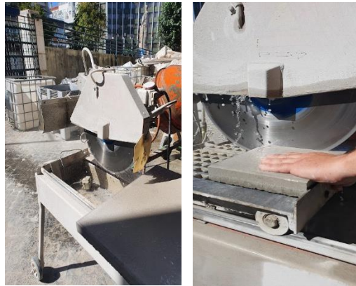
Figura 3.3 Cortes das lajetas de betão com serra em disco fino de aço.
